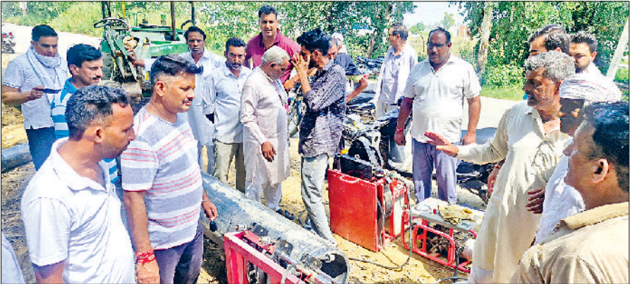
बांड। सीवरेज पाइपलाइन का कार्य रुकवाते चंदलाना के ग्रामीण।
